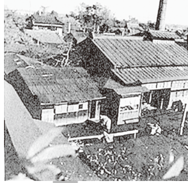
■堀田染色の工場全景
